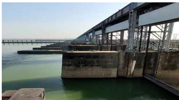
Fig.: Farakka Barrage
